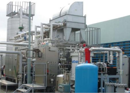
매립지, 하수처리시설 및 유기성폐기물자원화시설 등의 혐기성 소화설비에서 생산된 바이오가스를 정제하여 고순도의 바이오메탄을 생산하는 시설입니다. 생산된 고순도의 바이오메탄은 화석연료를 대체할 수 있는 자동차 연료로 사용됨으로써 대체에너지원 마련 및 기후변화에 적극적으로 대응할 수 있습니다. 한라산업개발(주)는 수도권매립지에 바이오가스 자동차연료화 시설의 설치 및 운영을 통하여 14,400Nm<sup>3</sup>/일 가량의 바이오메탄을 생산하여 버스 등 하루 200여대 차량에 연료로 공급하고 있습니다. 이를 기반으로 음식물류폐기물, 유기성슬러지, 음폐수 등 유기성폐기물을 자원화하기 위한 기술변화에 적극적으로 대응하고 있습니다. 바이오가스 자동차연료화 기술을 활용하여 CNG연료 차량의 보급 및 신재생에너지 보급률을 증대시키기 위해 노력하고 있습니다.
